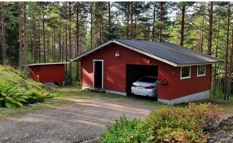
Kuva 13-14. Korttelin 3 talousrakennuksia (autokatos-varasto, oikeanpuolinen ja liiteri).
