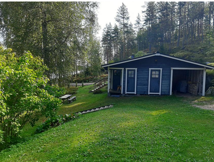
Kuva 10. Korttelin 2 talousrakennus (autokatos, varasto, sauna)
